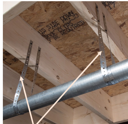
Supports métalliques en traction
